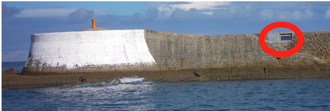
FIGURE 5.6 – Photo de la digue de l’Artha où se situe la station et le panneau photovoltaïque. N.B. : Les capteurs sont sur l’autre pan de mur du musoir peint en blanc.
