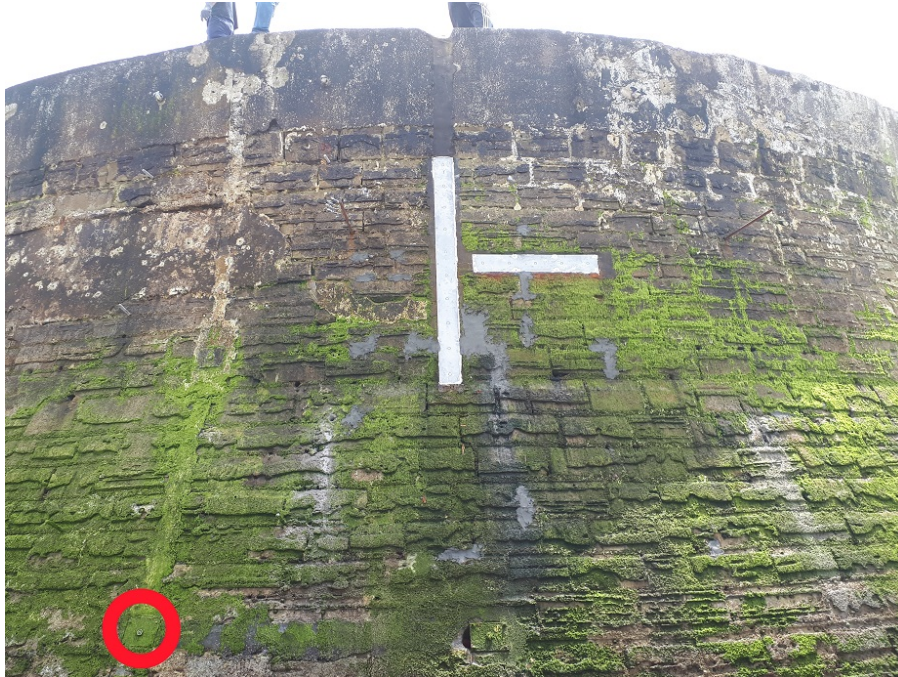
FIGURE 5.3 – Photo du mur avec les capteurs. Le capteur 0 est entouré en rouge.
